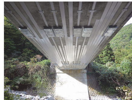
写真 - 4 下面補強工事の完成
