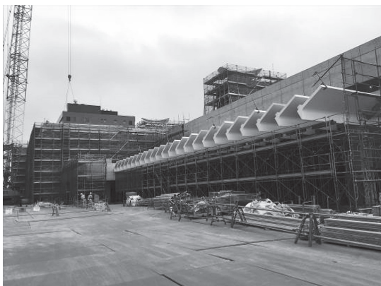
④ 車寄せ庇架設完了
