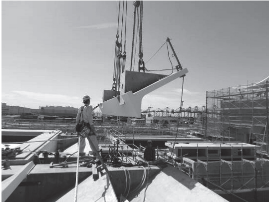
① プール目隠し架設
