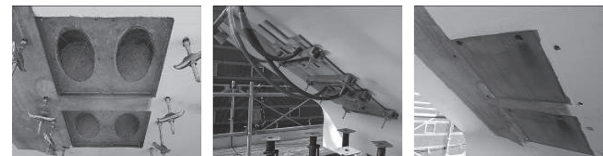
写真 - 10 固定側定着端部穴埋め状況
