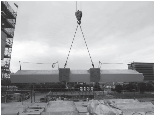
② 車寄せ庇架設
