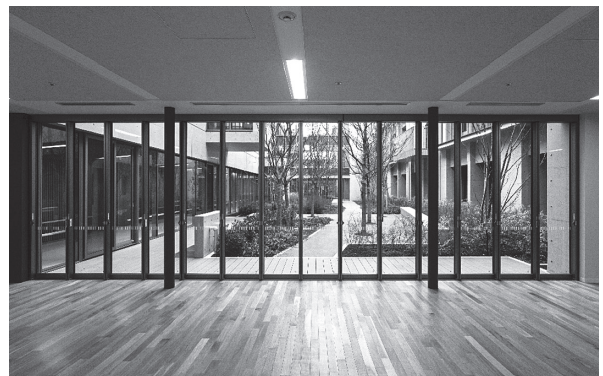
写真 - 4* フラットスラブとポスト柱による渡り廊下
