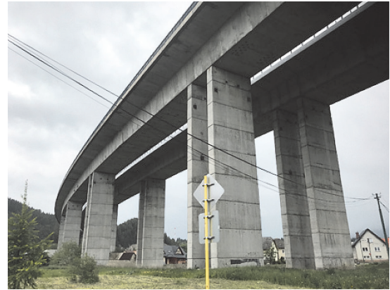
写真 - 1 PODTUREN VIADUCT
