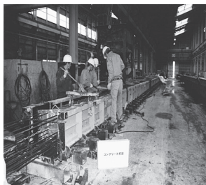
図 - 4 コンクリート打設
