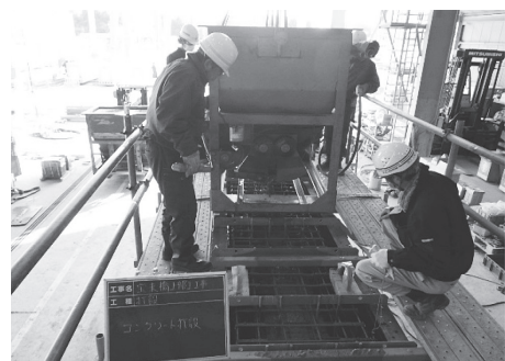
写真 - 6 打込み高さ確認状況
