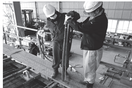
写真 - 5 内部振動機の挿入深さ確認状況
