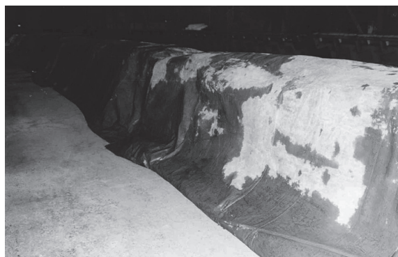
写真 - 8 養生状況
