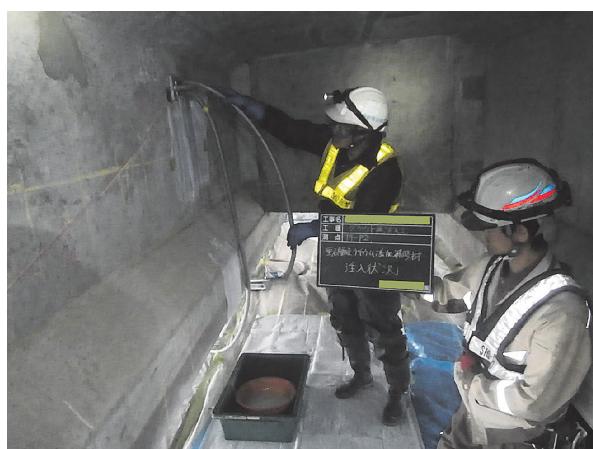
写真 - 5 補修材注入状況
