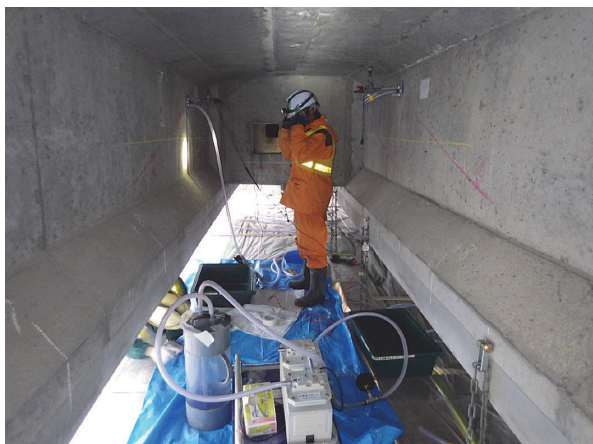
写真 - 3 亜硝酸リチウム水溶液注入状況
