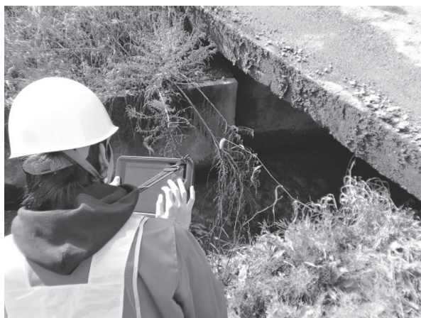
写真 - 1 タブレット端末による小規模橋梁点検試行
