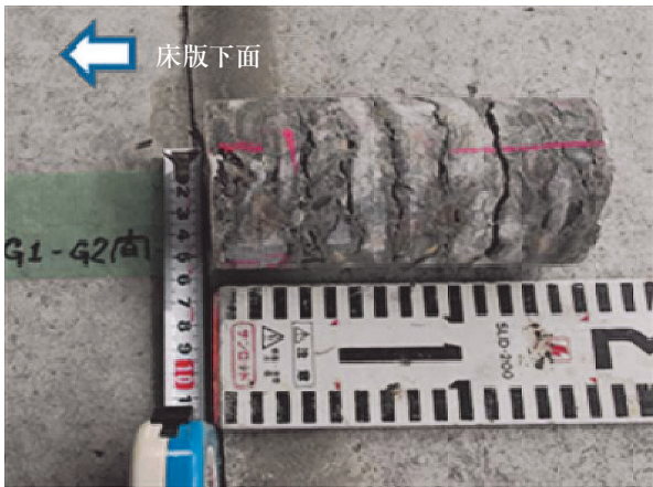
写真 - 2 RC床版損傷状況
