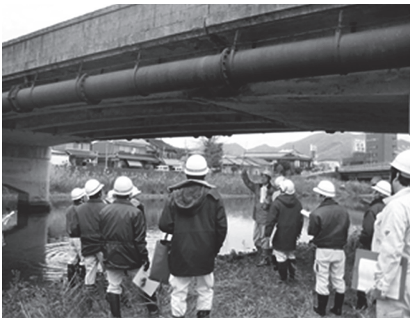
写真 - 2 橋守研修会の様子 (点検実習)
