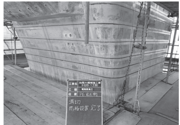
写真 - 7 溝切陽極設置完了
