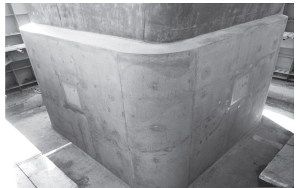
写真 - 3 コンクリート巻立て完了
