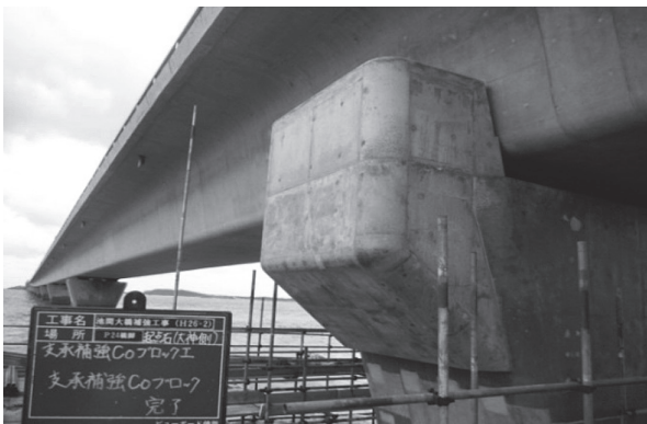
写真 - 5 支保補強完了
