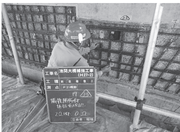
写真 - 8 犠牲陽極設置状況
