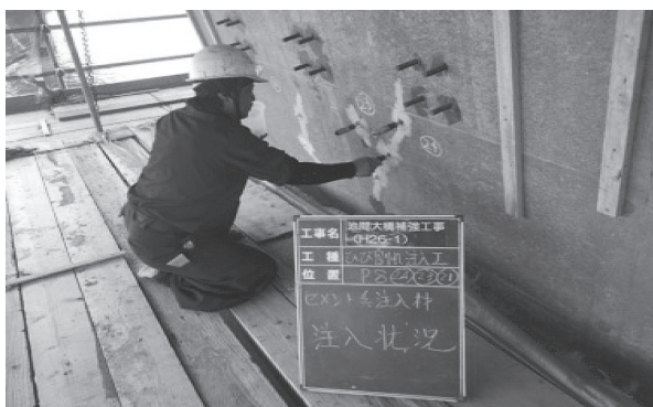
写真 - 9 ひび割れ注入工
