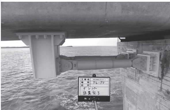
写真 - 6 ダンパー取付け完了
