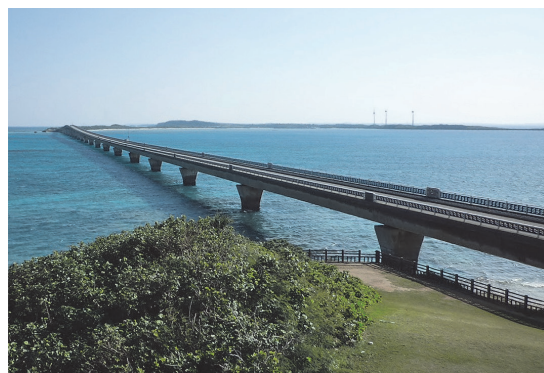
写真 - 1 池間大橋の写真（池間島より撮影）
