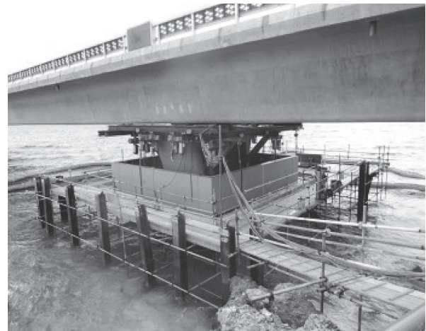
写真 - 10 圧入式鋼製パネル仮締切り工法の施工状況
