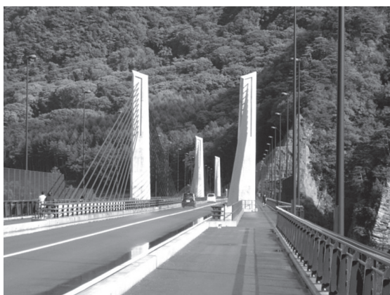
写真 - 6 不動大橋の主塔と橋面
