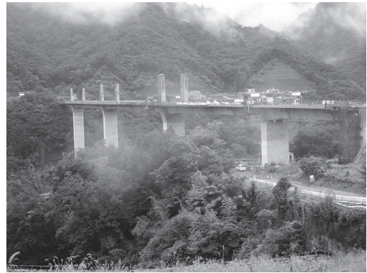
写真-1 八ッ場大橋（建造中）
