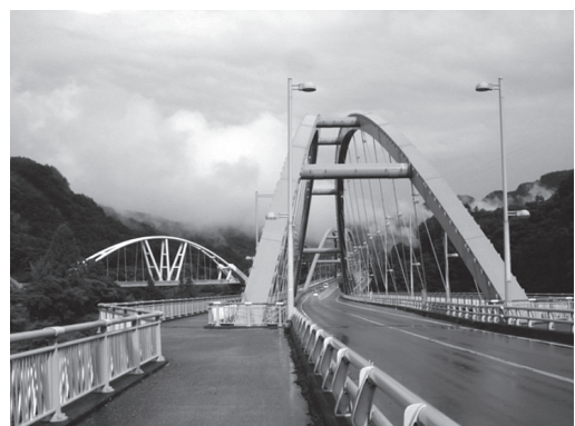
写真-4 長野原めがね橋 (後方左側は第三吾妻川橋梁)
