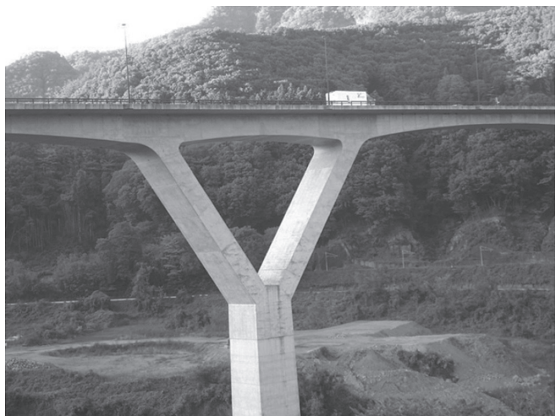
写真 - 5 丸岩大橋のY字形橋脚
