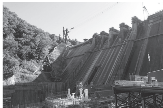
写真 - 9 ハッ場ダム（下流、左岸から）
