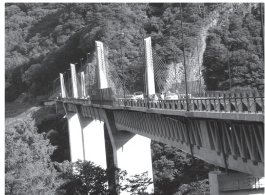
写真-2 鋼・コンクリート複合トラス構造の不動大橋
