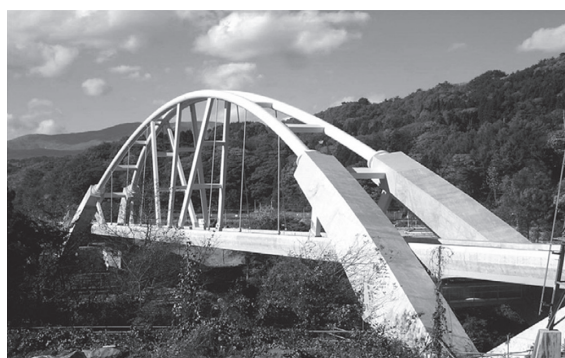
写真 - 8 第三吾妻川橋梁
