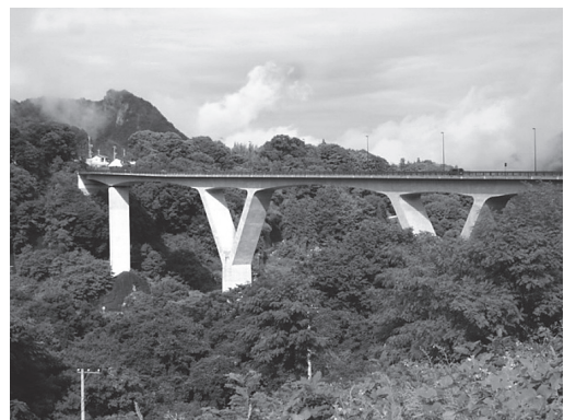
写真-3 Y字形橋脚の丸岩大橋
