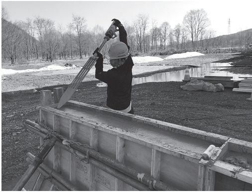
写真 - 17 壁高欄試験施工状況
