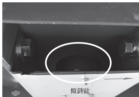
写真 - 11 型枠傾斜計設置状況
