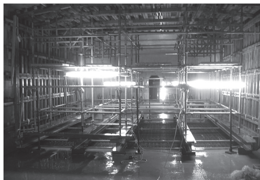
写真-15 一般的な内部支保工の施工状況
