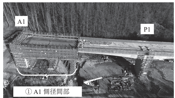
写真 - 13 側径間施工状況
