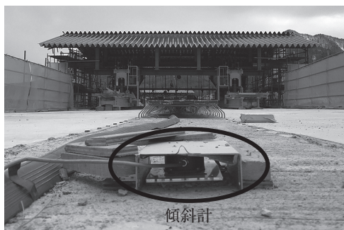
写真 - 9 橋面傾斜計設置状況
