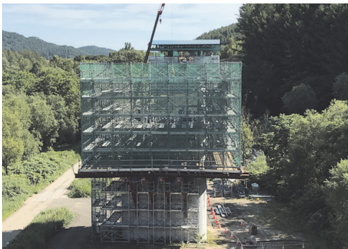
写真 - 1 柱頭部施工状況
