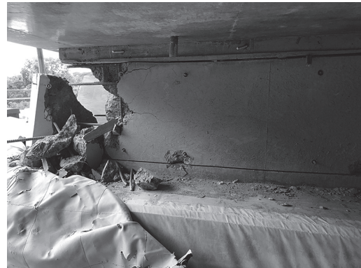
写真 - 20 放電破碎後
