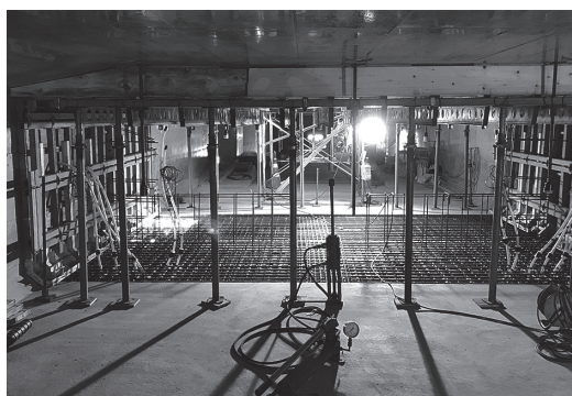
写真-16 ペコビームの施工状況
