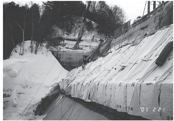
写真-4 上部RC版の打替え
