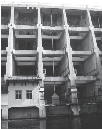
写真 - 2 バットレスダムの扶壁、遮水壁および横梁
