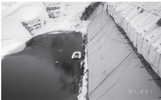
写真 - 3 PC版により補修された遮水壁
