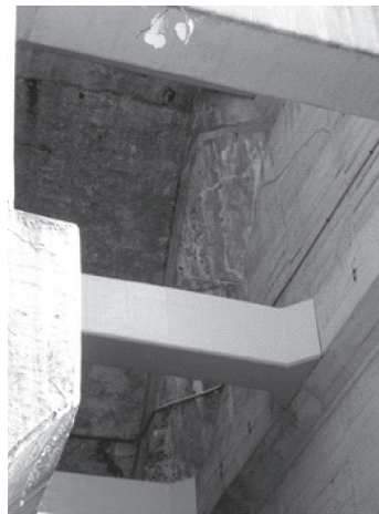
写真-5 横梁の補強
