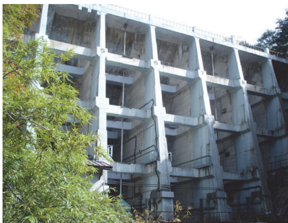
写真 - 1 バットレス形式の丸沼ダム
