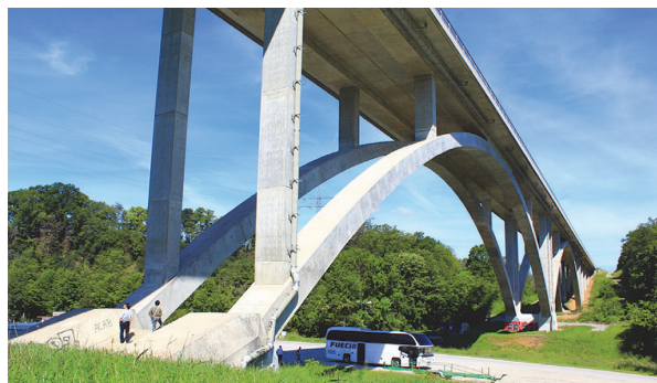
写真 - 15 ムルバレー高架橋
