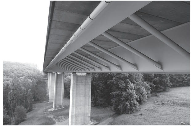
写真 - 7 フラビンカ高架橋
