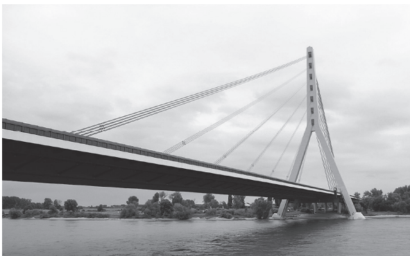
写真 - 9 フレーエ橋
