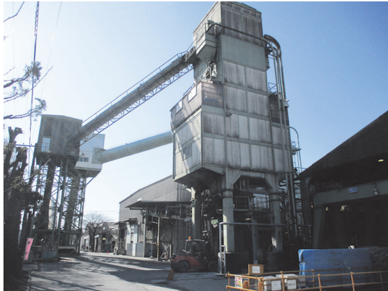
写真 - 3 バッチャープラント
