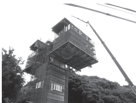
写真 - 4 張出し架設工法（移動作業車）
