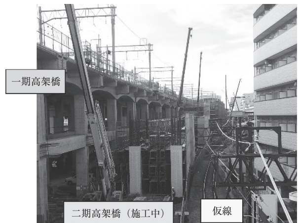
写真 - 3 高架橋上部工構築時の状況
