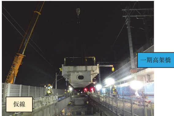
写真 - 4 鋼桁の撤去状況
