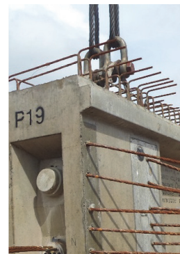
(c) 吊り状況
