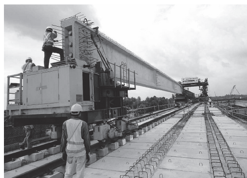
写真 - 6 桁の上をレールと専用の台車で運搬する例
