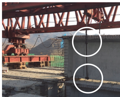
写真 - 1 ポステン桁の吊り方 ①
