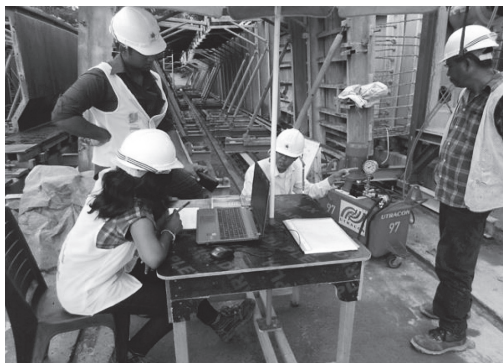
写真 - 8 一般的な緊張作業の例
