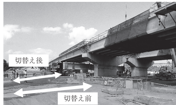
写真 - 9 既存道路の上空に桁を架設するために道路を切り替えた例
