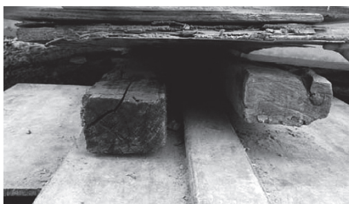
写真 - 3 不適切な木材を桁の支点に使用した例
