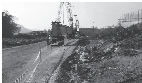
写真 - 5 仮設道路境界をテープで明示した例
