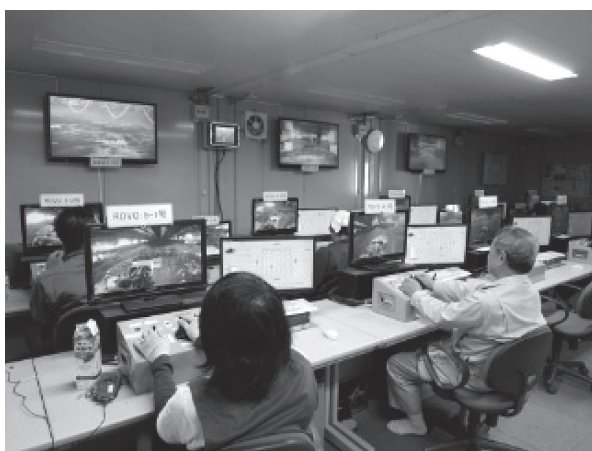
写真 - 4 ニューマチックケーソンの遠隔操作状況
