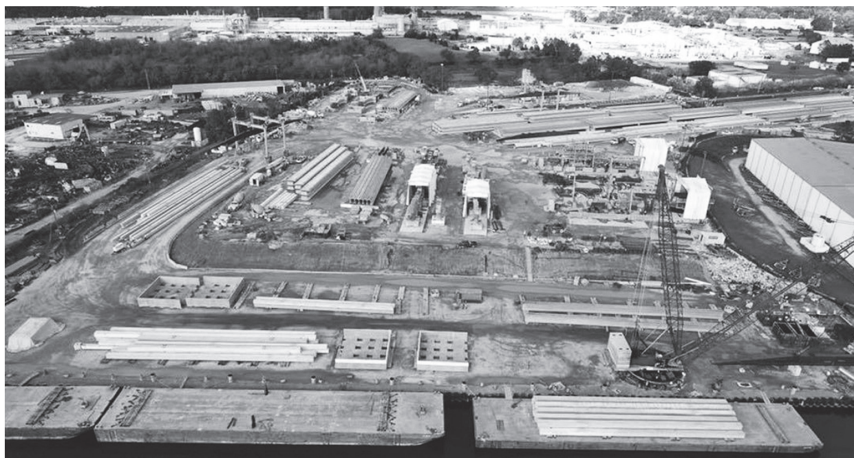
図-3 プレキャストコンクリート製造ヤード
