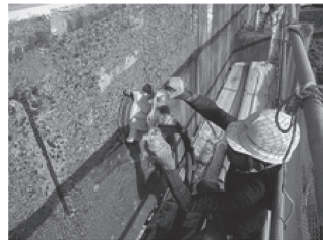
写真-2 表面処理状況
