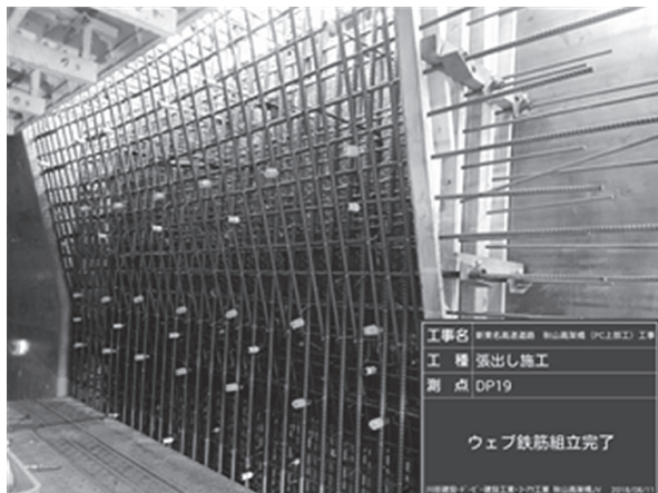
写真 - 1 ウェブ鉄筋組立完了
