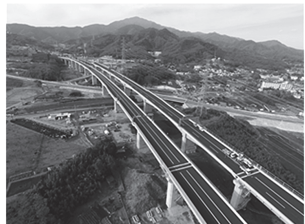
写真-2 完成写真
