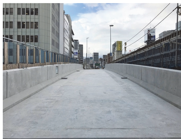
写真 - 12 完成状況（橋面から）
