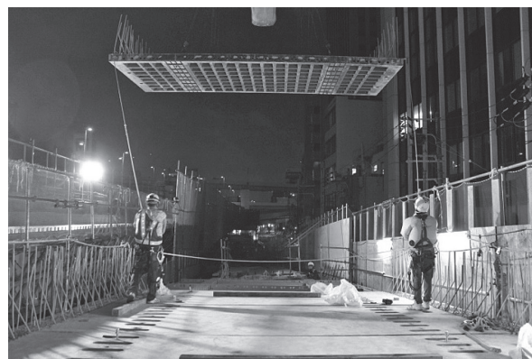
写真 - 8 床版設置状況
