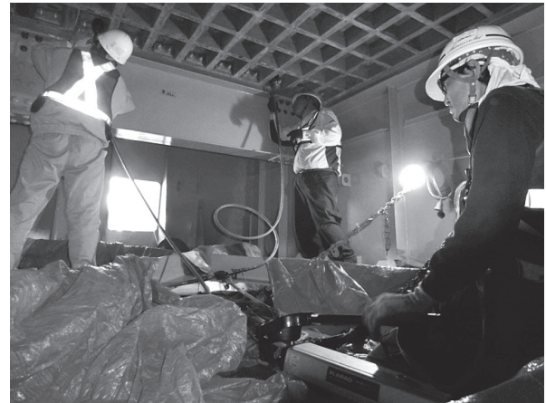
写真 - 10 接合部緊張状況
