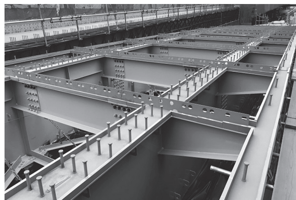
写真 - 6 架設前の鋼主桁
