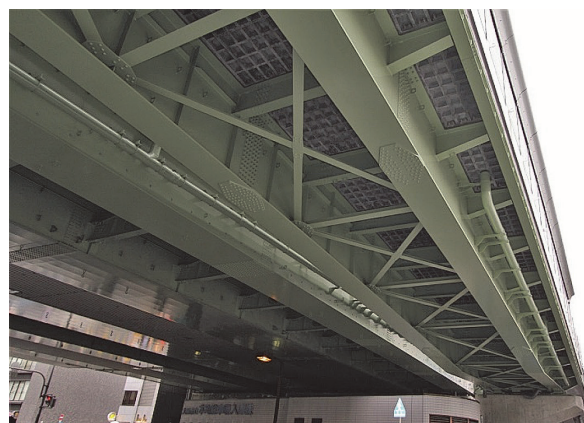
写真 - 11 完成状況（下面から）
