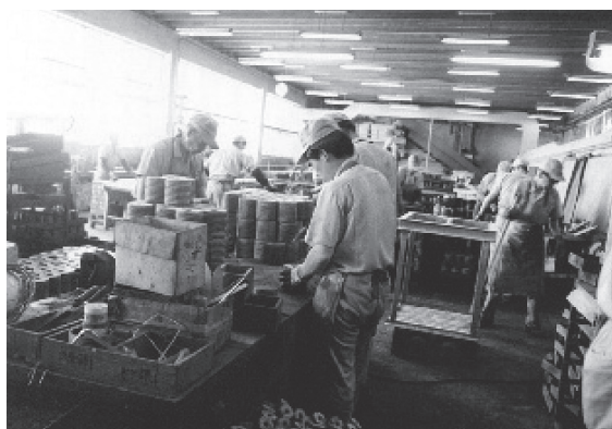
写真 - 3 モルタル製フレシネーコーンの製造状況 （最盛期は昼夜交替で製造にあたった）
