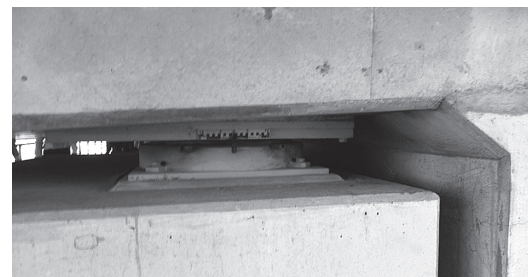
写真 - 5 支承部に設置された変位計
