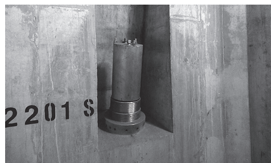
写真 - 6 主塔内斜材定着部
