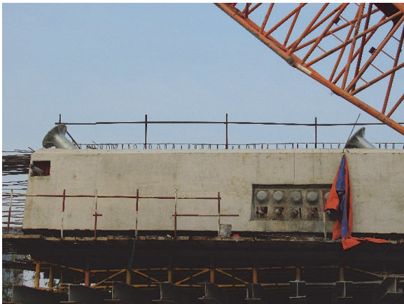
写真 - 7 コンクリート桁部の斜材定着部
