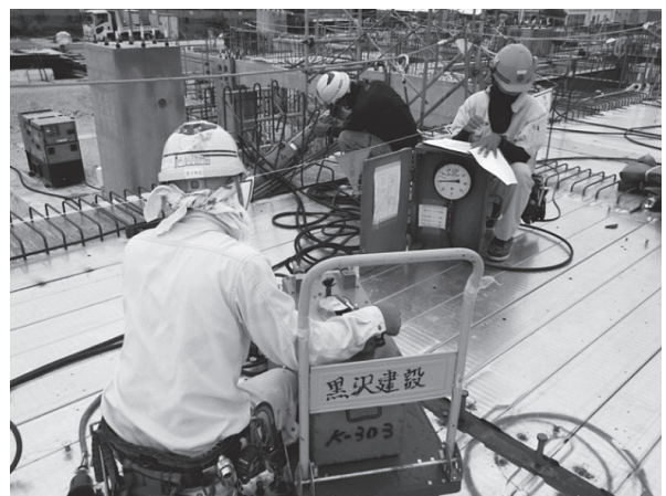
写真 - 17 緊張状況
