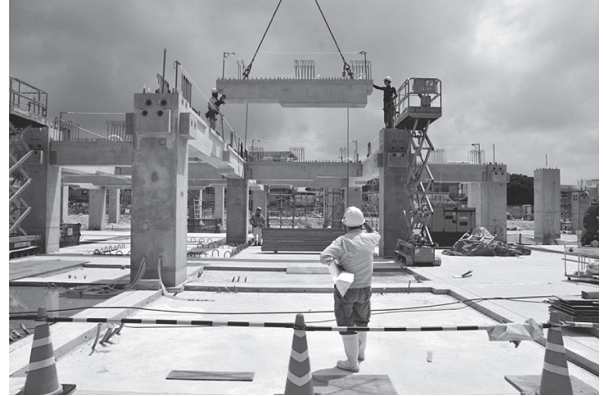
写真 - 16 梁の架設 (6m スパン)
