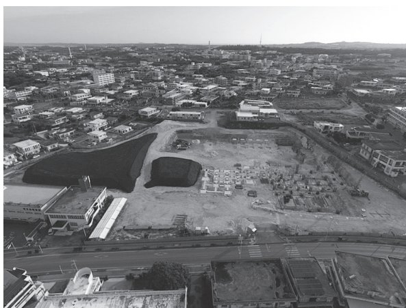
写真 - 3 既設レベルに合せた基礎
