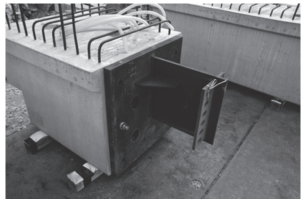
写真 - 8 片持ち梁 PCa 部材
