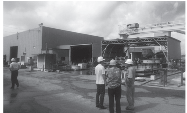
写真 - 13 部材製造工場
