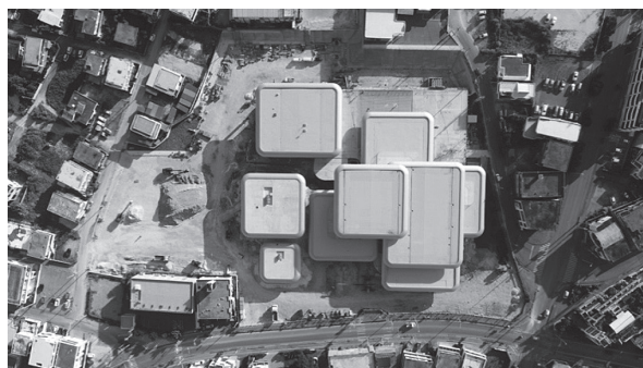
写真 - 4 重なる屋根（施工中）
