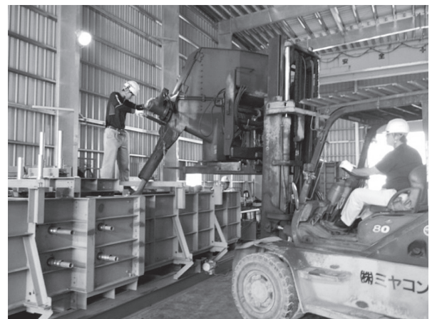
写真 - 15 打設状況
