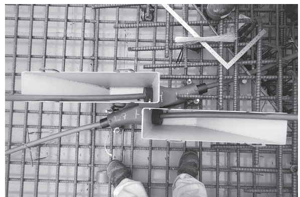
写真 - 9 アンボンド PC 鋼より線および H 型アンカー設置状況
