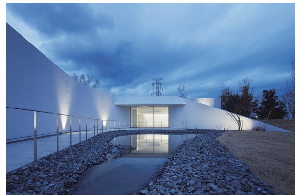
*写真-5 建物外観(ヒバリの庭から見る)
