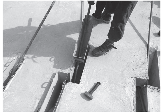
写真 - 12 鋼製型枠の脱型状況
