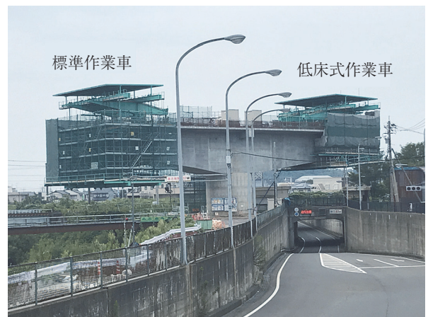
写真 - 2 低床式作業車による張出し施工
