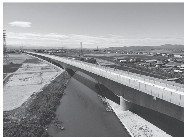
写真-6 完成写真
