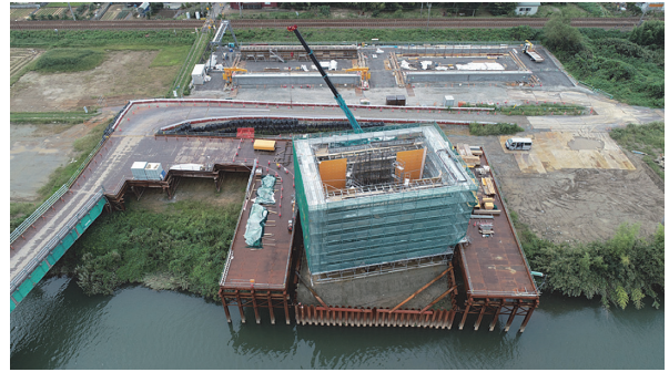
写真 - 1 出水期における仮締切内の柱頭部支保工
