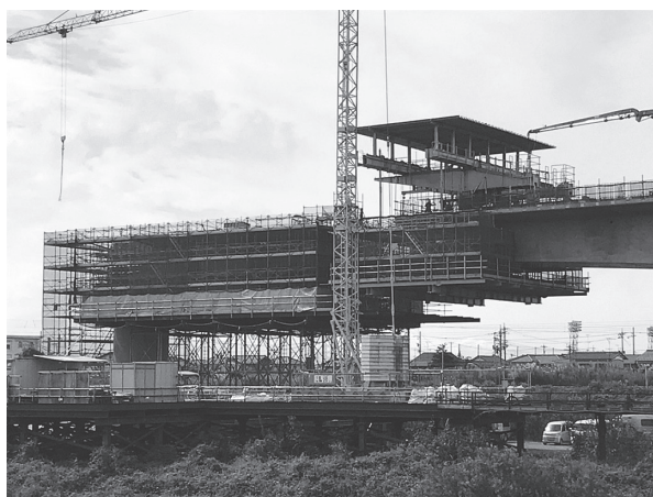
写真-3 側径間施工状況
