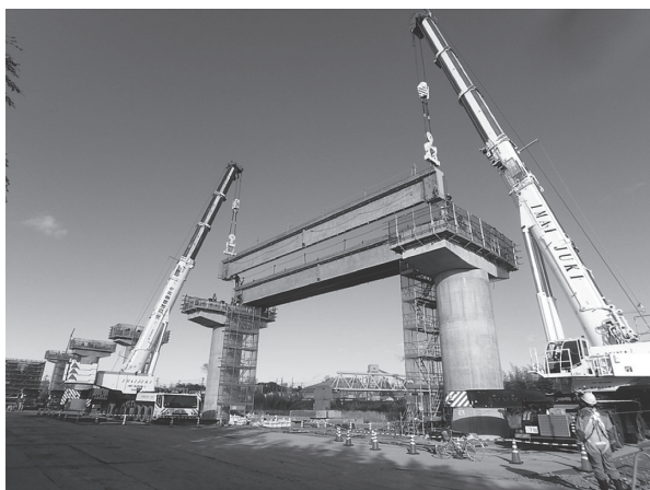
写真-5 PC桁架設
