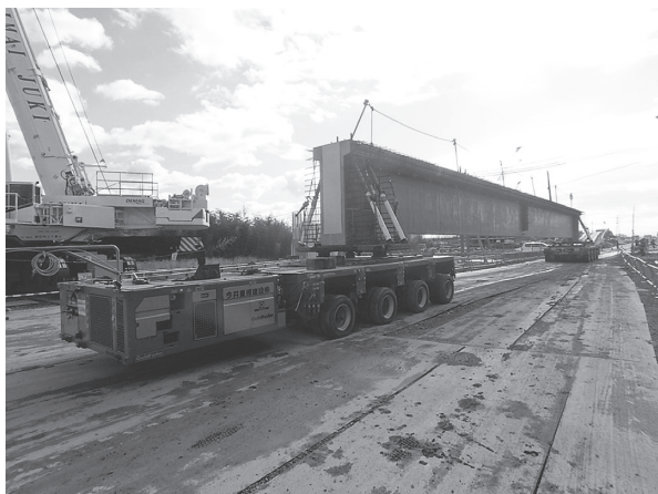
写真-4 大型多軸台車によるPC桁運搬
