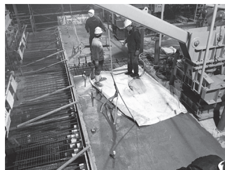
写真 - 2 真空脱水状況
