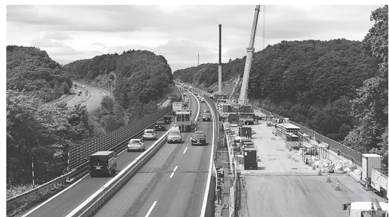
写真 - 2 島松川橋床版取替工事の状況
