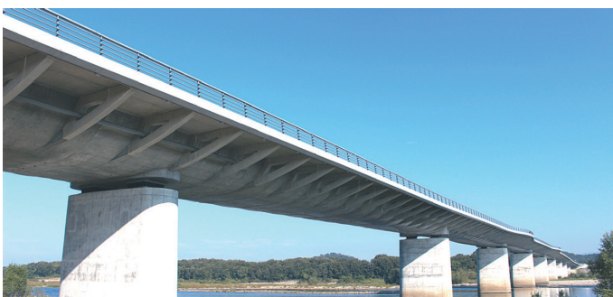
写真 - 1 各務原大橋（10 径間連続フィンバック PC 橋）
