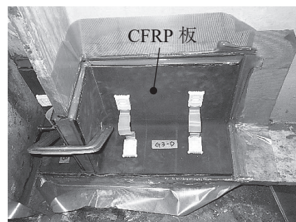
写真 - 9 CFRP 板による補強
