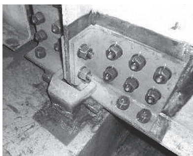
写真 - 8 当て板による補強
