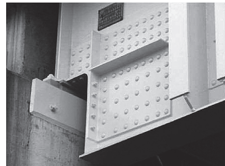
写真 - 6 桁端切欠き部の補強事例
