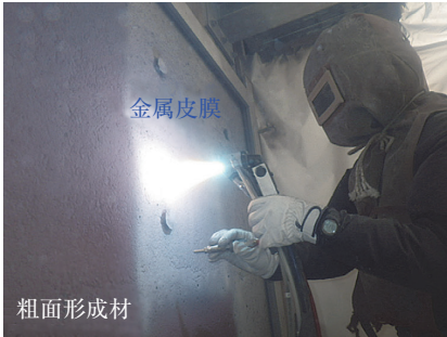
写真 - 1 プラズマ溶射の状況
