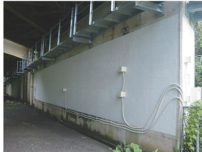
写真 - 2 配線・配管後の施工面
