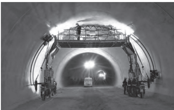
図 - 4 交通を通しながら行える移動型（可変構造） トンネル全断面点検システム
