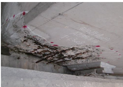
(a) コンクリート桁の桁端部
