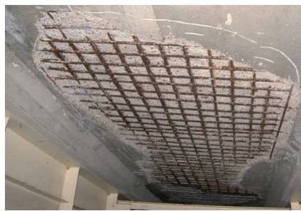
(b) 鉄筋コンクリート床版
