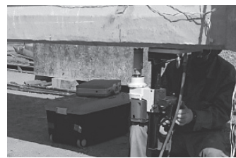
写真 - 2 コア応力解放法の調査状況
