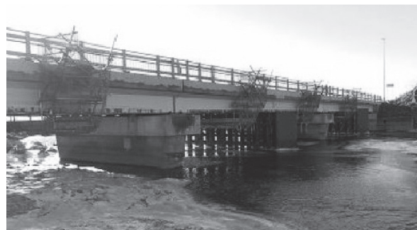
写真 - 1 調査対象橋梁全景（撤去前）
