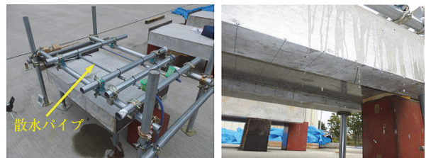
(1) 散水状況 (2) 水切り底面
