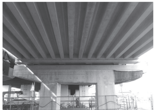
写真 - 16 架替え完了状況（桁下）
