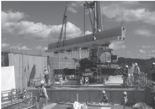
写真 - 8 横梁架設状況
