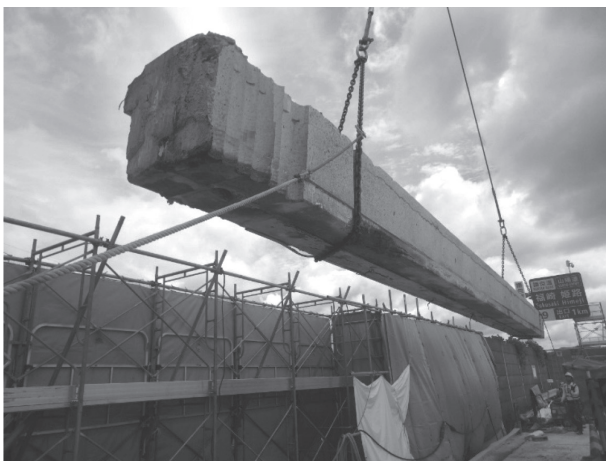
写真 - 7 桁吊上げ撤去状況
