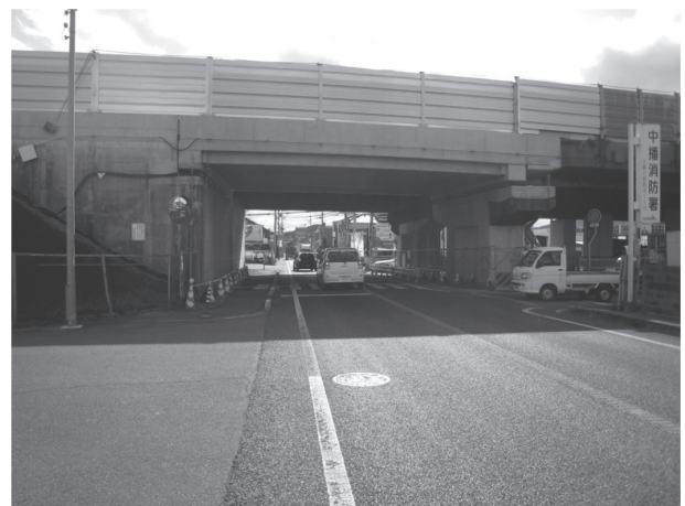
写真 - 17 架替え完了状況（側面）
