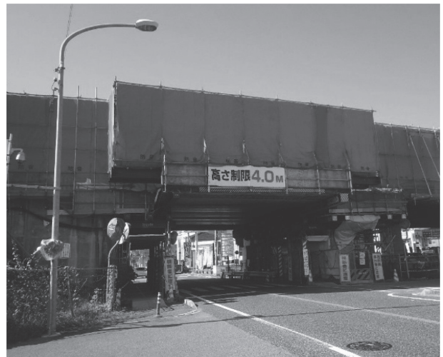
写真 - 4 桁下防護設置完了
