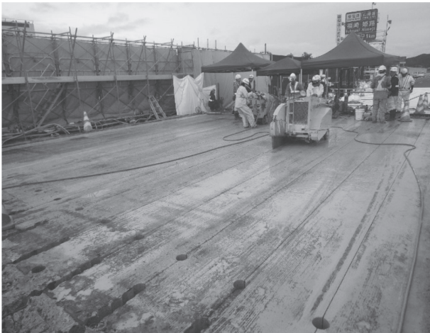
写真 - 5 桁切断状況
