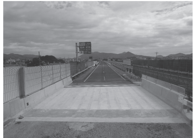
写真 - 15 架替え完了状況（橋面）
