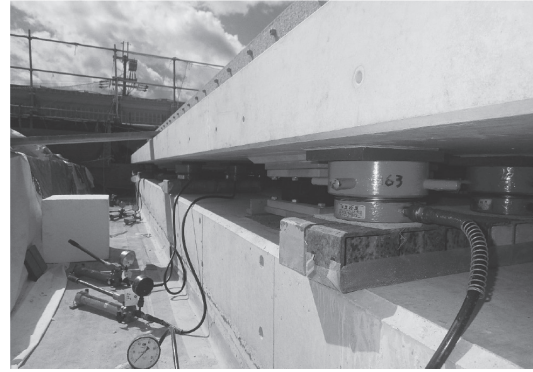
写真 - 10 油圧ジャッキによる横梁保持
