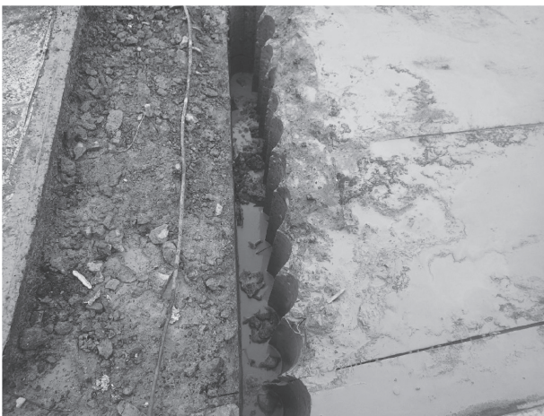
写真 - 6 遊間部連孔穿孔
