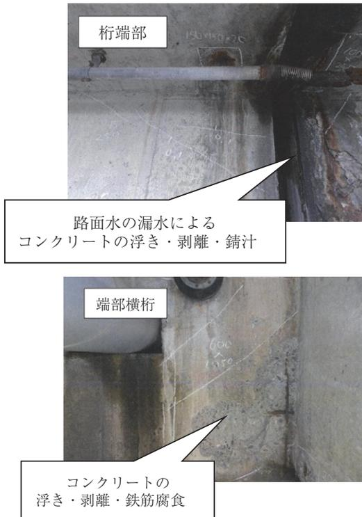
写真 - 2 桁端部の代表的な劣化状況
