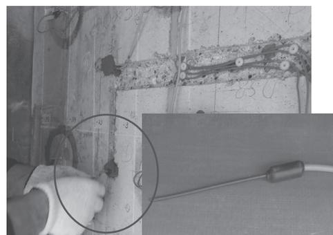
写真 - 6 チタン製ワイヤーセンサー<sup>8)</sup>の設置状況
