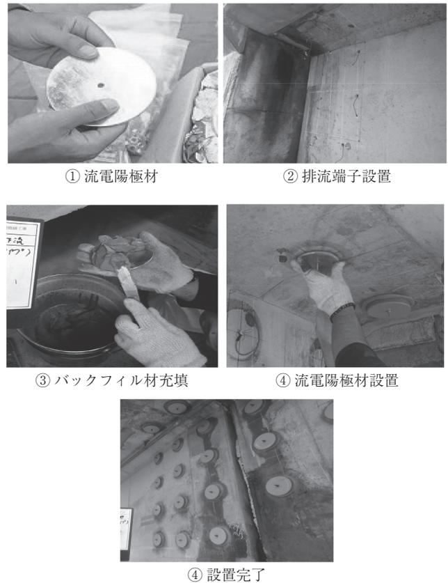
写真 - 5 表面設置タイプ流電陽極材の設置状況
