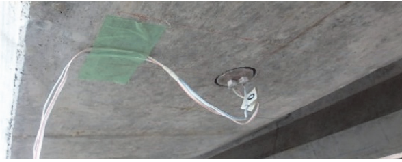
写真 - 1 残存プレストレス測定状況
