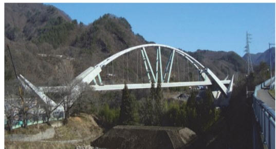
写真 - 4 第 3 吾妻川橋梁 (2011 年)
