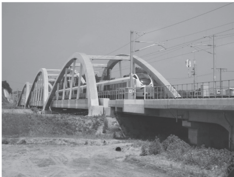
写真 - 6 青い森鉄道の天間川橋梁（2006年）
