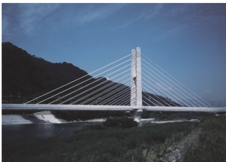
写真 - 2 第 2 千曲川橋梁 (1996 年)
