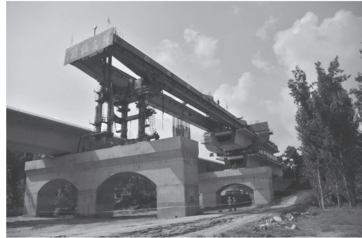
写真 - 8 建設中の新幹線高架橋（中国）
