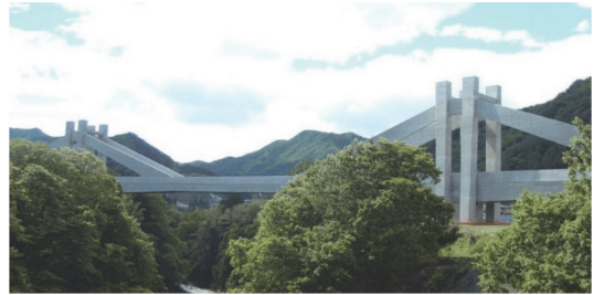
写真 - 3 第 2 吾妻川橋梁 (2010 年)
