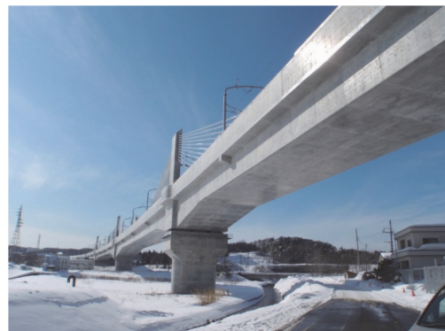
写真 - 5 三内丸山高架橋 (2008 年)
