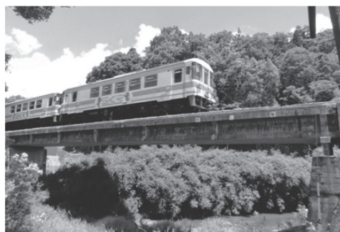
写真 - 1 信楽高原鉄道第一大戸川橋梁
