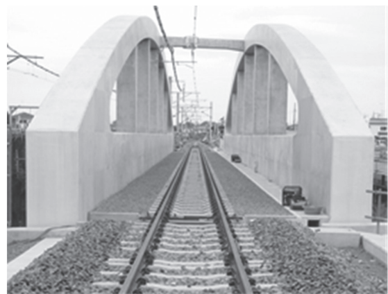
写真-2 新小出川橋梁完成状況 1)
