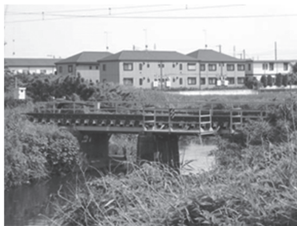
写真 - 1 旧小出川橋梁 1)
