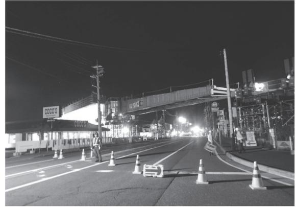
写真 - 13 第 1 開発 Bv 夜間押し出し架設
