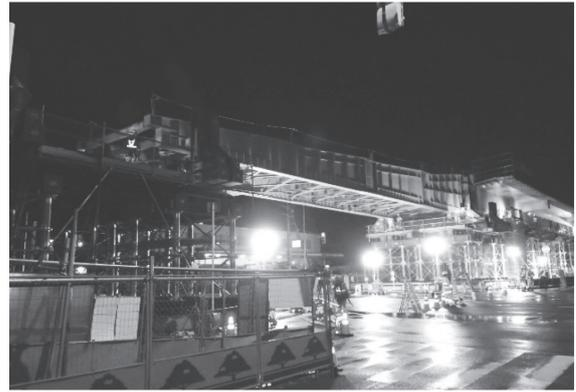
写真 - 9 第2寺前 Bv 夜間押し出し架設
