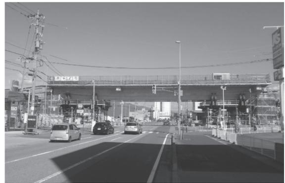
写真 - 10 第2寺前 Bv 押し出し架設全景
