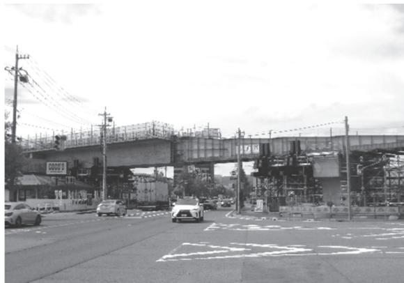
写真 - 14 第 1 開発 Bv 押し出し架設全景
