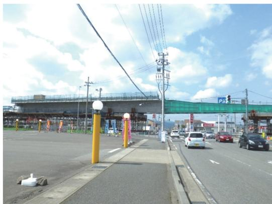
写真 - 6 第 2 高柳 Bv 押し架設 1 日目
