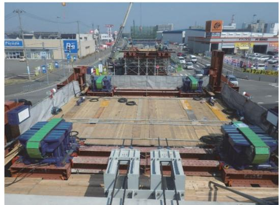
写真 - 8 仮支柱上エンドレス滑り装置
