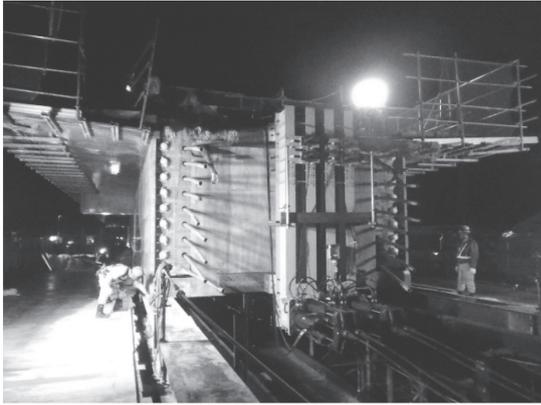
写真 - 11 高木 Bv 夜間押し出し架設
