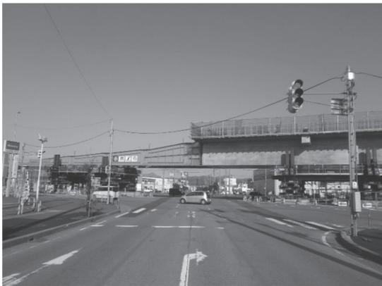
写真 - 12 高木 Bv 押し出し架設全景
