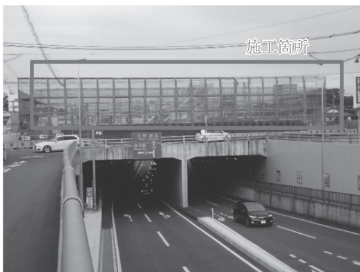
写真 - 9 架設位置 (永昌架道橋)
