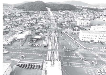
写真 - 2 架設状況 (第2平山架道橋)
