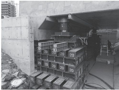
写真 - 13 ベント設置状況
