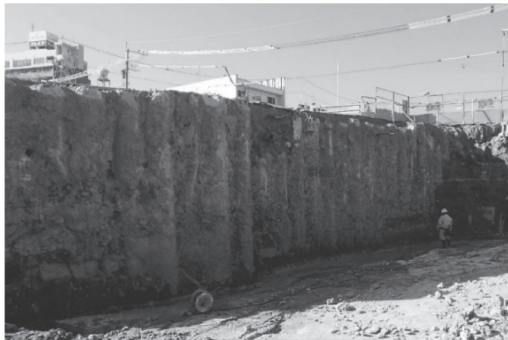
写真 - 10 ソイルセメント系柱列式連続壁の出現
