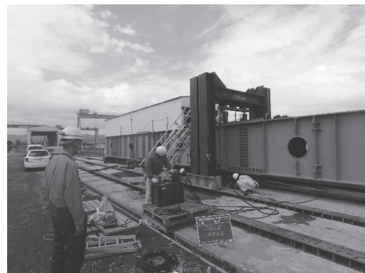
写真 - 12 架設桁の載荷試験
