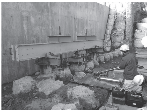
写真 - 11 押込み載荷試験
