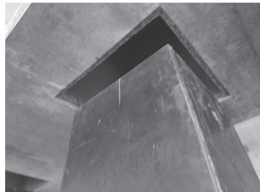
写真 - 14 固定ストッパー切欠
