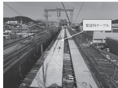
写真 - 3 架設外ケーブル (第2平山架道橋)
