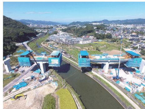
写真 - 6 架設状況 (東大川橋梁)
