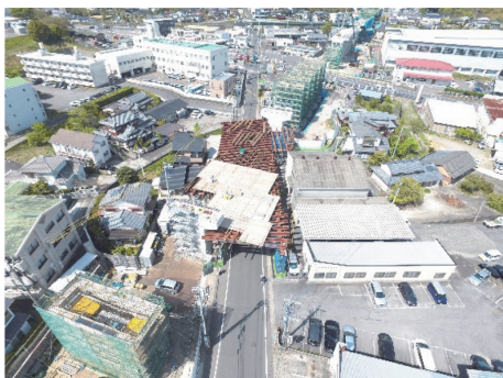
写真 - 5 架設状況 (第3平山架道橋)
