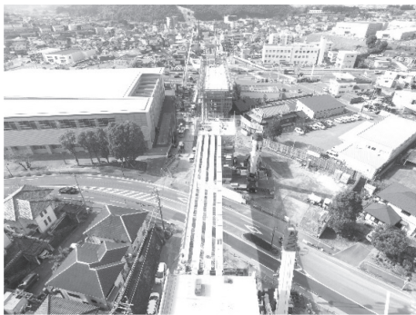
写真 - 1 架設状況 (第1平山架道橋)
