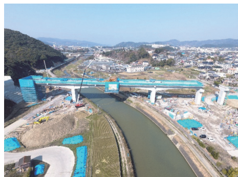
写真 - 7 中央閉合部施工状況 (東大川橋梁)
