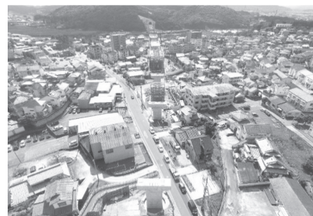
写真 - 4 着工前状況 (第3平山架道橋)
