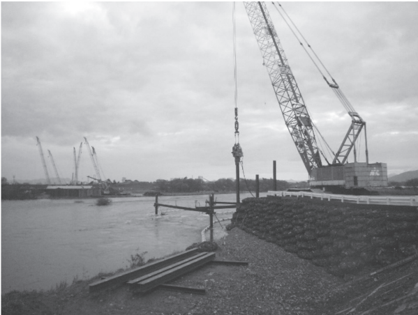
写真 - 1 H鋼杭打設状況
