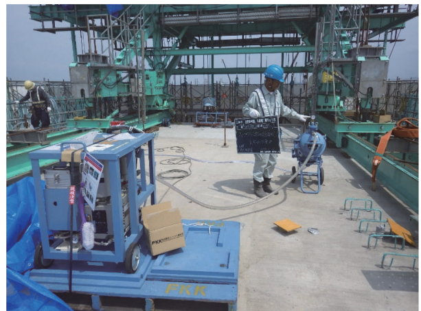
写真 - 9 真空グラウト工法施工状況
