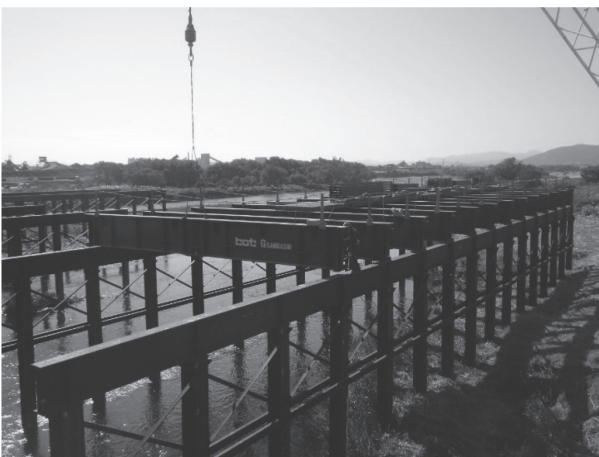
写真 - 2 仮橋組立状況
