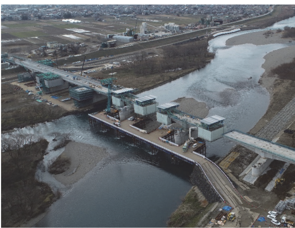
写真 - 7 張出し架設施工状況
