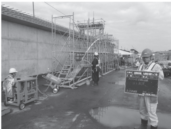
写真 - 10 真空グラウト工法施工状況
