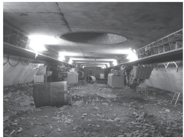
写真 - 3 刃口内掘削状況
