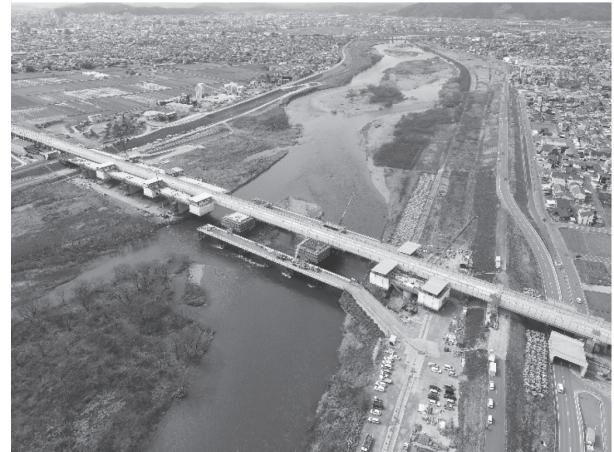
写真 - 11 鉄道橋施工完了時全景
