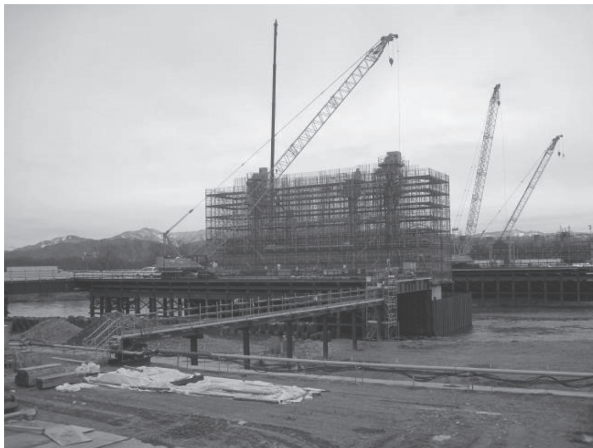
写真 - 4 橋脚施工状況
