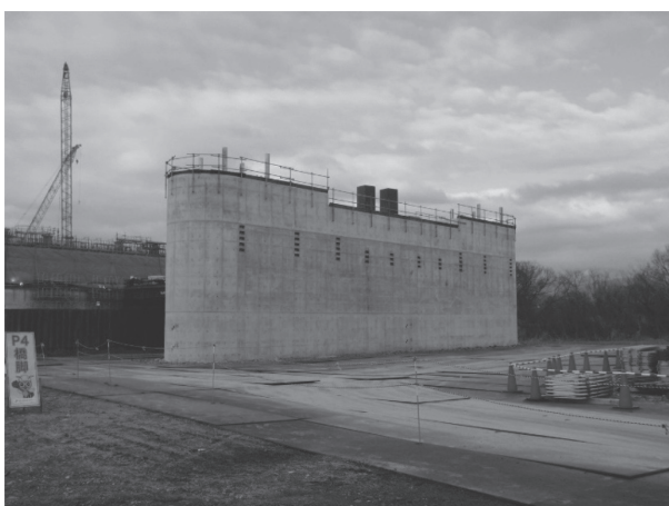
写真 - 5 橋脚全景写真
