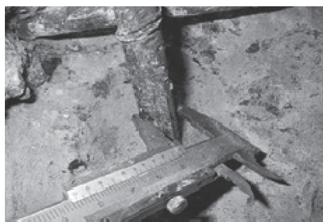
写真-2 鉄筋径の計測状況
