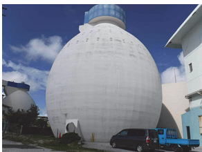
写真 - 1 PC タンク外観
