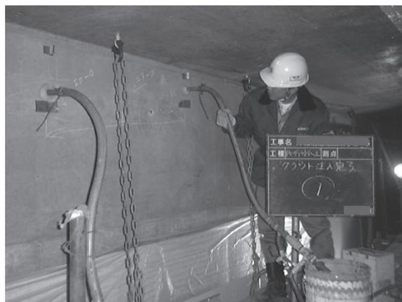
写真-2 PCグラウト再注入作業（2穴方式）
