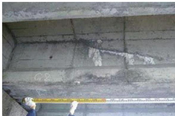
写真 - 1 主桁側面シース沿い変状例
