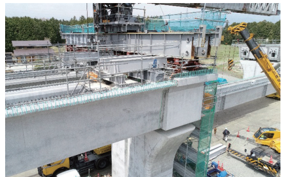
写真 - 4 セッティングビームによる架設状況
