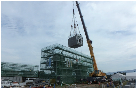
写真 - 3 プレキャスト柱頭部の架設状況
