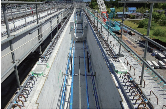
写真 - 2 構造を簡素化したプレキャスト桁
