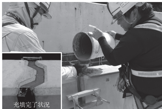
写真 - 10 壁高欄目地の充填状況
