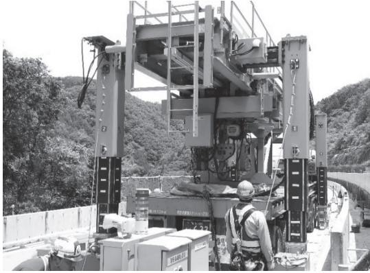
写真 - 8 架設機の組立て
