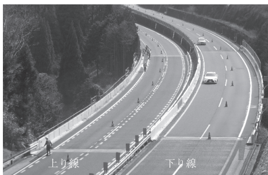
写真 - 1 大谷橋全景
