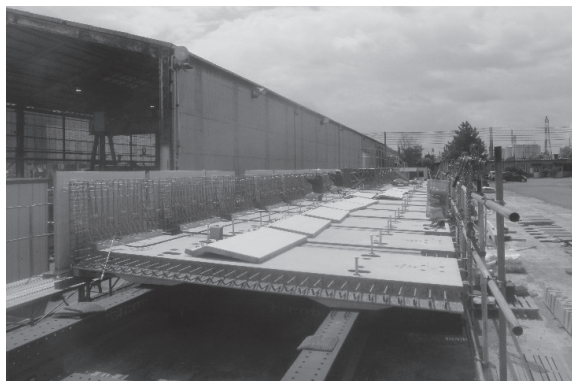
写真-6 1期施工側壁高欄の製作状況
